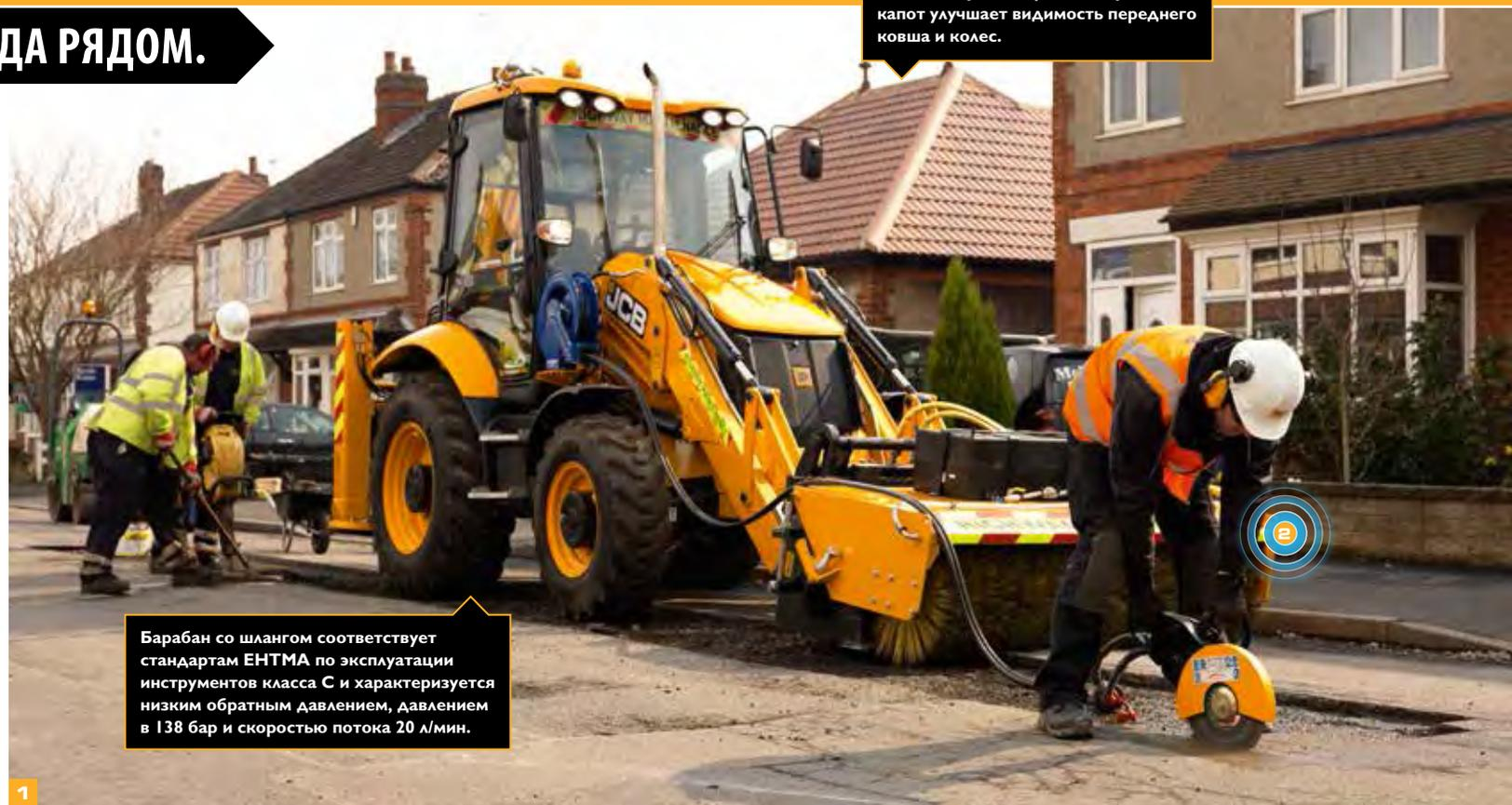
Барaban со шлангом соответствует стандартам ЕНТМА по эксплуатации инструментов класса С и характеризуется низким обратным давлением, давлением в 138 бар и скоростью потока 20 л/мин.
