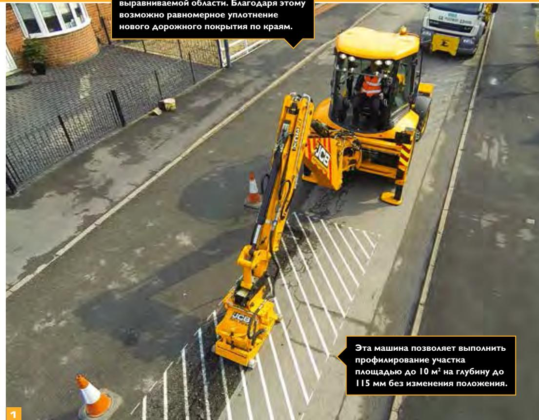
Мощный высокоскоростной барабан ровно срезает вертикальные края любой выравниваемой области. Благодаря этому возможно равномерное уплотнение нового дорожного покрытия по краям.
